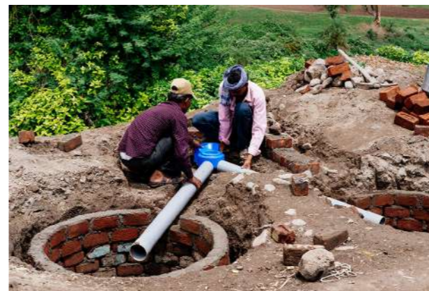
「SATO Vトラップ」を施工する様子
