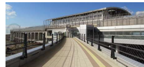
視覚障がい者用誘導ブロック(セラミック)に、「クールイエロー」を追加した例
