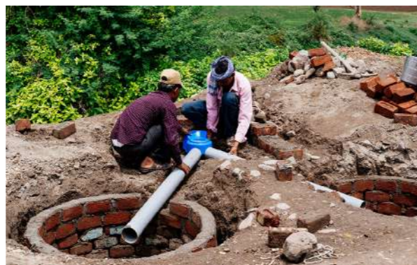
「SATO Vトラップ」を施工する様子
