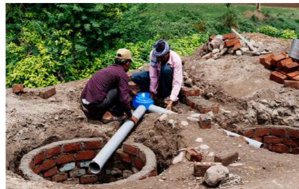
「SATO Vトラップ」を施工する様子
